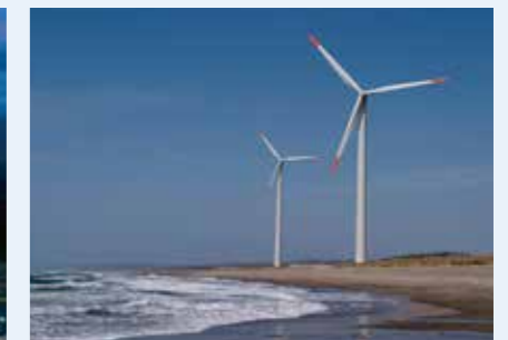
風力発電システム
