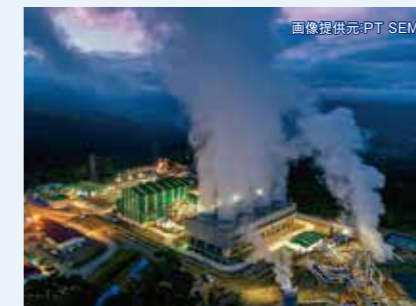
地熱発電設備
