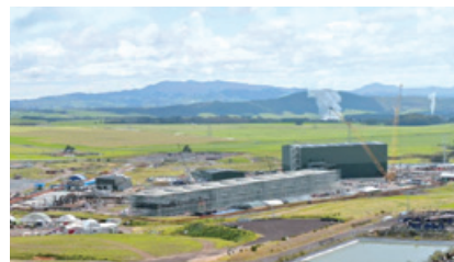
建設中のタウハラ地熱発電所 (ニュージーランド)
