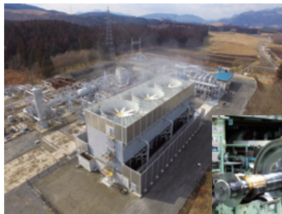
出光大分地熱株式会社様 涌上バイナリー発電所
