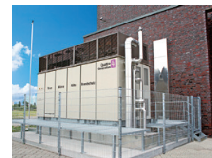
低酸素防火システムの燃料電池（ドイツ・ヴィスマール市）
