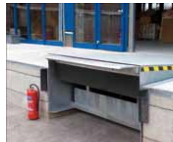
搬出入戸口の床の調整に
