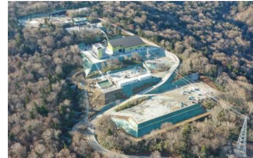
岩手県 安比地熱発電所 14.9MW
