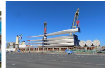
愛知県内某 風力発電所建設現場
