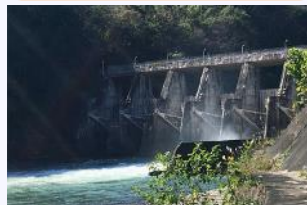
水力発電設備
