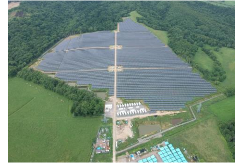
グリーン電力(株)様 (画像提供元) GPD尾幌太陽光発電所
