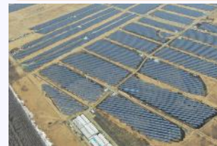
太陽光発電システム
