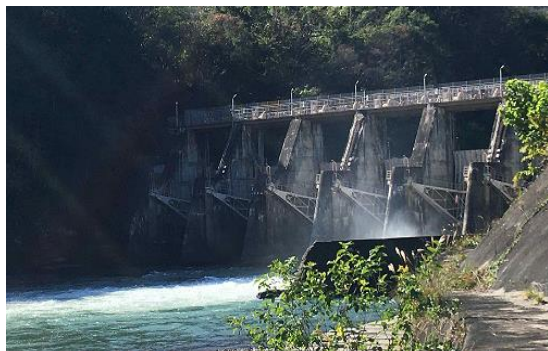
東京電力リニューアブルパワー(株)様 (画像提供元) 笹平発電所
