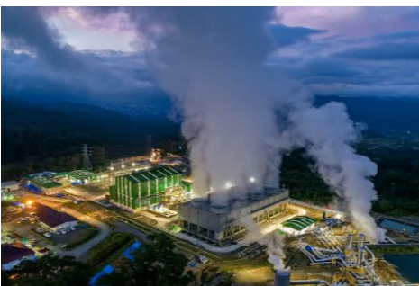
PT SEML様 (画像提供元) Muara Laboh Geothermal Power Plant
