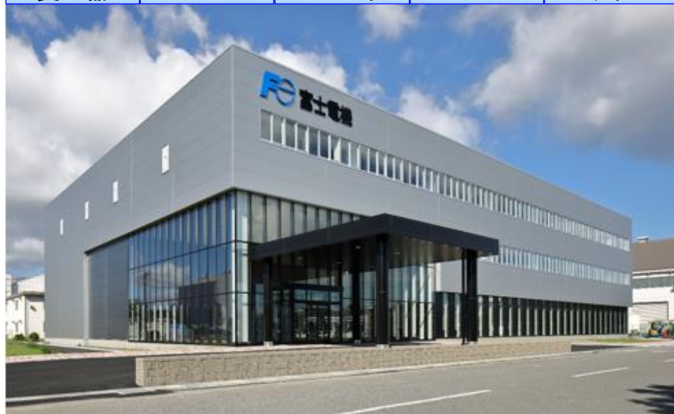
千葉工場新棟 延べ床面積: 7,000m 2 、2020年12月稼働予定
