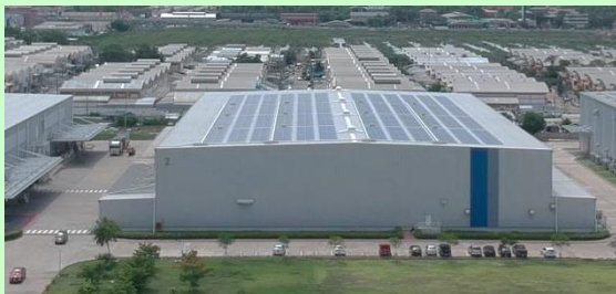
第2工場 産業変電ユニット
