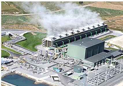
地熱発電所 (フラッシュ式)
