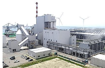
バイオマス発電所
