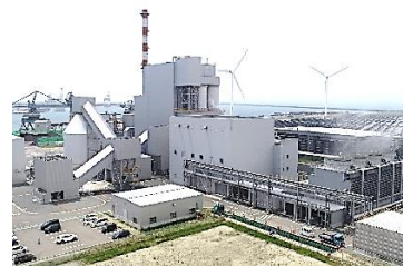
バイオマス発電所
