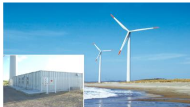
西目風力発電所
