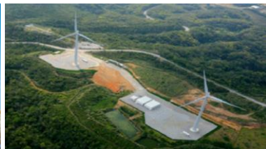
大宜味風力発電 実証研究設備
