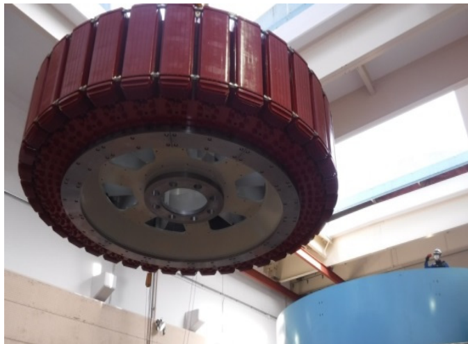
【水車・発電機更新事例】
