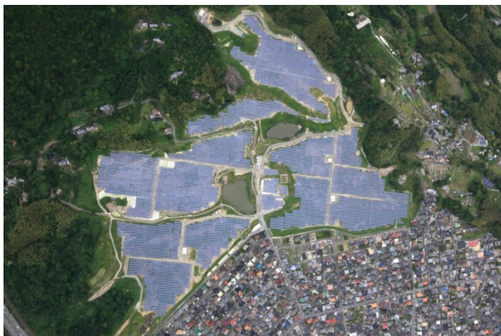
光エナジー合同会社様 山口県光市メガソーラー (EPC案件 AC14MW) 2017年1月納入
