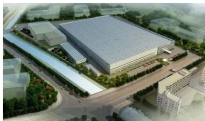
大連・第二工場 2016年7月着工
