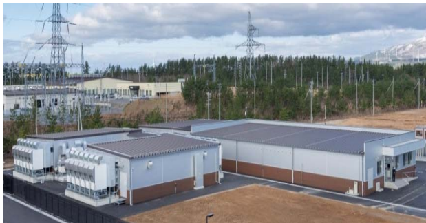
モジュール型IDC (雪氷冷房を適用:世界初)
