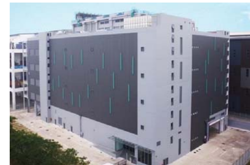
ビル型IDC (屋内設備一式施工)
