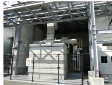
NEDO水素社会構築技術開発事業で納入した「S-Formerシリーズ」(10MW級大型水電解装置向け)
