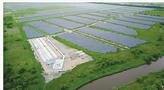
すずらん釧路町太陽光発電所
