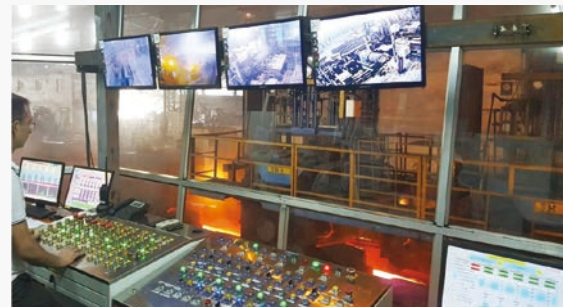
監視・制御室(インドの鉄鋼プラント)
