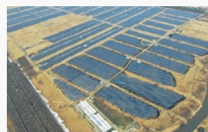
すずらん釧路町太陽光発電所
