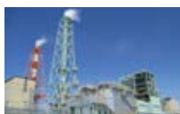
名古屋第二発電所 (バイオマス発電)
