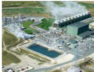
地熱発電設備
