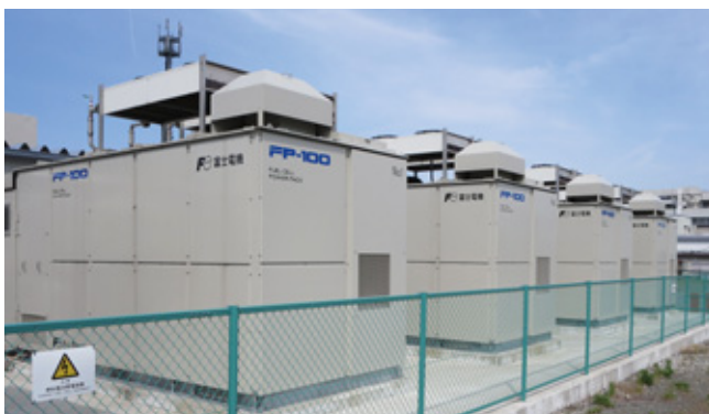
スマート化のモデル工場(山梨製作所)に設置した当社の燃料電池
