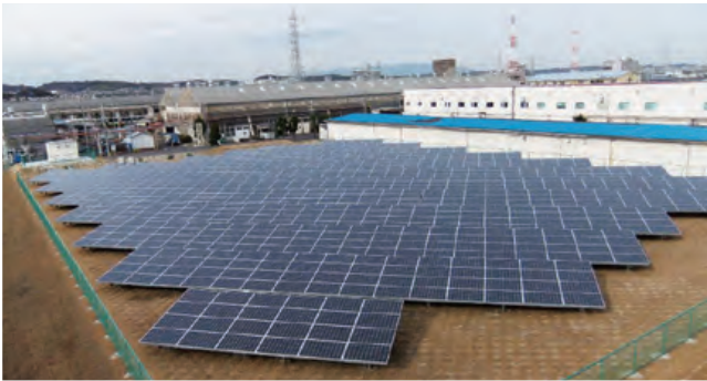
スマート化のモデル工場に導入した太陽光発電システム(三重工場)
