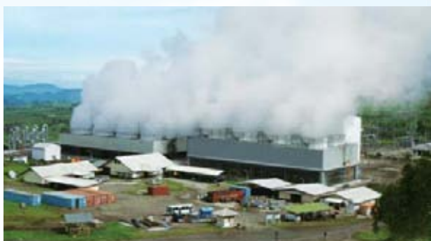
インドネシアのワヤンウィンドゥ地熱発電所
