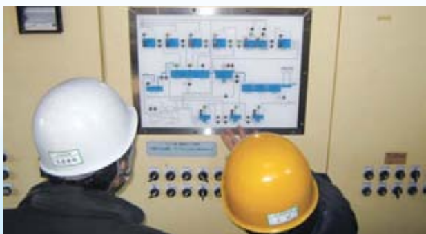
川崎工場におけるグリーンファクトリー・グリーンオフィス評価の現場確認
