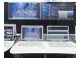
地域エネルギー管理システム
