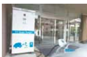
EV用急速充電器
