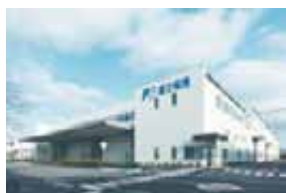
三重工場 新製造棟 ・建築面積:9,308m 2 ・延床面積:1万3,135m 2
