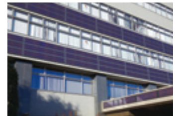
太陽光発電設備を設置した東京工場
