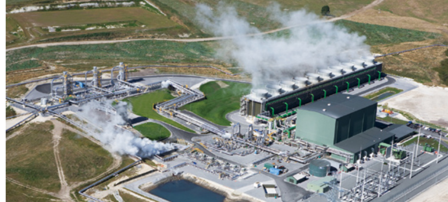
ナ・アワ・プリア地熱発電所(ニュージーランド)
