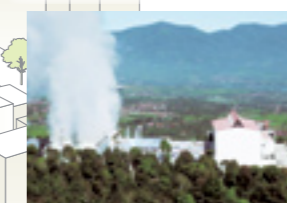
地熱発電設備
