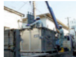
高濃度PCB使用機器の搬出
