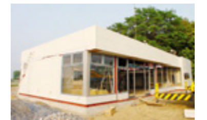
建物の外装や内装を工場ユニット化し、現地で組み立てる工法を採用している富士電機リテイルシステムズの「エコユニット」は、工期短縮、店舗のリユースや廃材のリサイクルを通じた環境負荷低減をコンセプトにした商品です。
