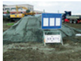
土壌・地下水浄化工事
