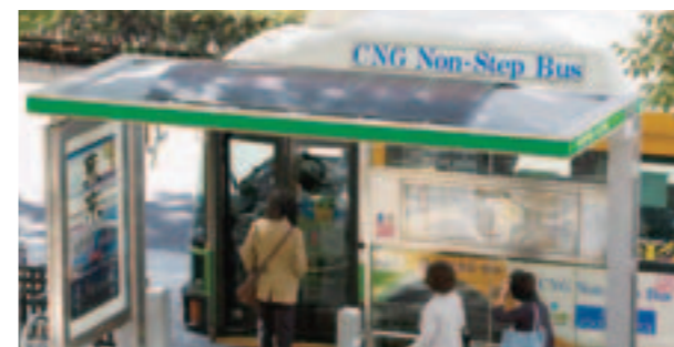
バス停の屋根にフィルム型アモルファス太陽電池を設置し、夜間照明などの電源として利用しています(東京都交通局様の試作品)
