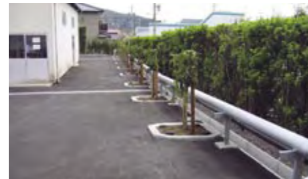
工事完了(土壌入れ替え後にアスファルトで舗装)
