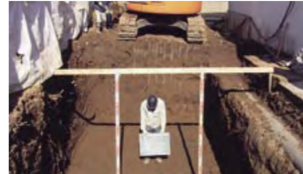
工事中(汚染土壌の掘削除去工事)
