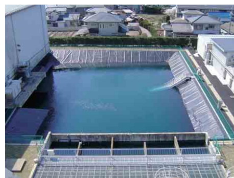
松本事業所では地下水浄化対策として、汚染土壌除去後に遮水シートを設置
