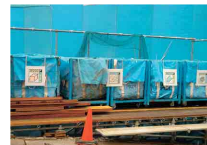
住宅建設工事における産業廃棄物の分別収集の徹底
