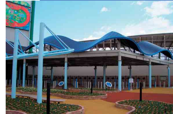
愛知万博ではワンダーサーカス電力館のウェイティングスペースの屋根に富士電機の太陽電池（10kW）を設置。発電した電力は、パビリオンで使用されている。
