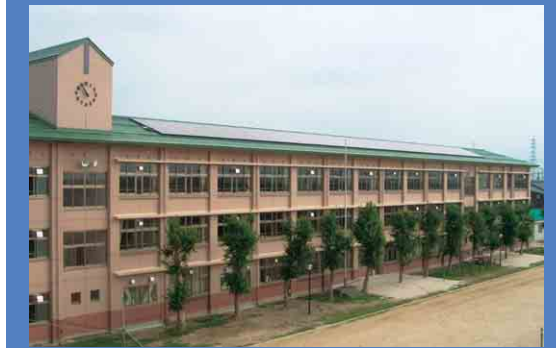
富士電機の太陽電池を設置した滋賀県の中学校。学校は夜間電力をほとんど使わないため、太陽電池の使用に適している。
