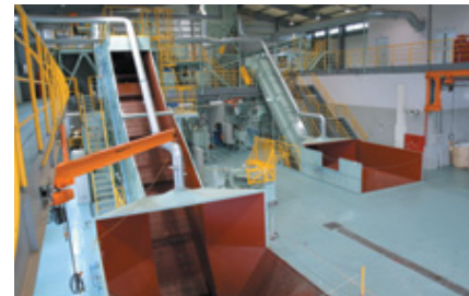
1日約3トンの一般廃棄物を処理できるリサイクル施設
