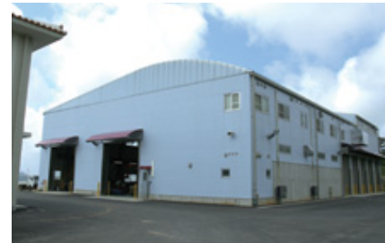
汚水処理など公害防止に万全を期した久米島リサイクルセンター
