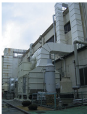
DCMの回収効率を上げる溶剤排気濃縮装置(富士電機デバイステクノロジー・松本事業所)
