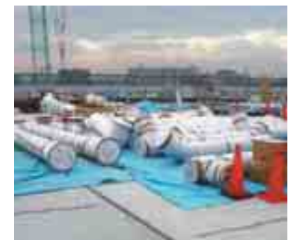
■ 水処理施設工事において、予め配管をプレハブ化。現地での加工、酸洗、端材搬出などによる騒音、有害ガス、産業廃棄物の発生を抑制 (富士電機工事)
