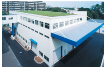
物流センターの屋上緑化(富士電機システムズ・東京事業所)
