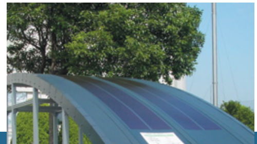
建材一体型アモルファス太陽電池パネル。工場や公共施設など、面積の広い屋根への設置が広がると期待されている。
