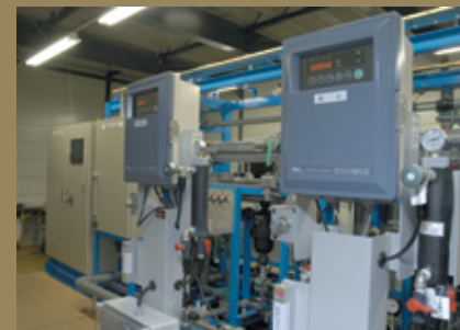
現在、山口市水道局をはじめ、国内4か所でパイロット試験を実施しています。写真は、膜ろ過システム(左)と計測システム(右)
