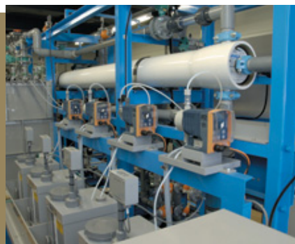
現在、山口市水道局をはじめ、国内4か所でパイロット試験を実施しています。写真は、膜ろ過システム(左)と計測システム(右)
