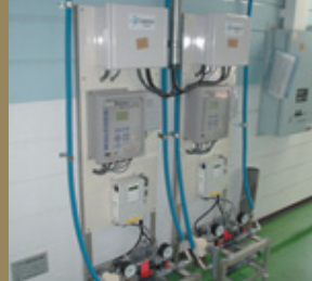
IWM冷却水処理サービス 薬品注入システム
