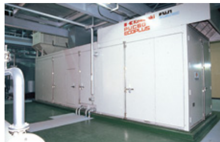
フル稼働を開始したガスタービン・コージェネレーションシステム(富士電機デバイステクノロジー・松本事業所)
