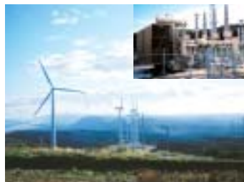
風力発電所変電設備と風車発電機
