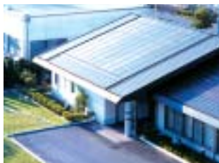
富士電機総合研究所で実証試験を継続している建材一体型太陽電池
