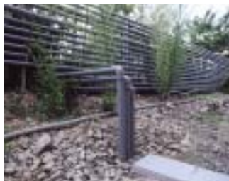
土壌汚染の浄化設備(安曇富士)
