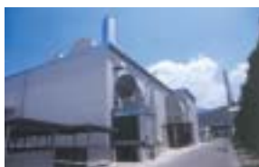
松本事業所内に建設されたコージェネレーション施設
