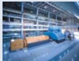
火力発電所用電気発生装置 電源開発向け磯子火力発電所の新1号機用として納入した「600MW電気発生装置」は世界トップレベルの出力を誇っています。
