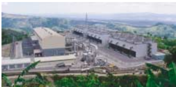
マリトポグ(フィリピン)地熱発電設備
