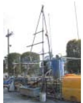
ボーリング調査
